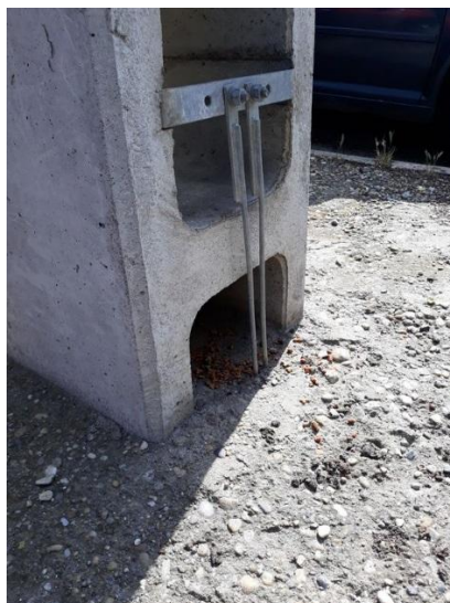
22. Kép Oszlop földelés nem sérülhet
