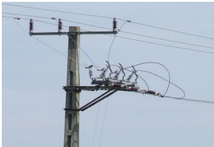
10. Kép Vízszintes leágazó oszlopkapcsoló
