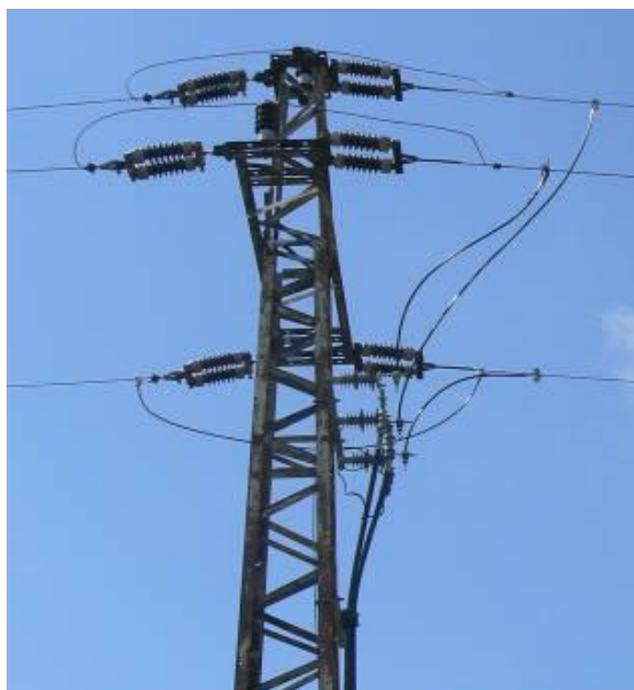
15. Kép 20 kV-os kábelindítás oszlopkapcsoló nélkül
