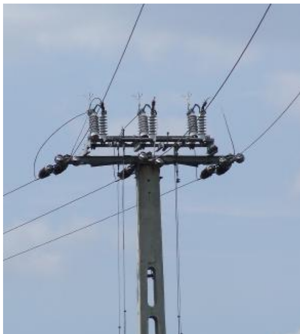
9. Kép Oszlopkapcsoló kétoldalas hajtásvezetéssel
