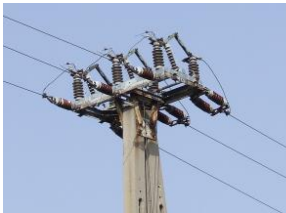
8. Kép Oszlopcsúcson elhelyezkedő gerincbontó oszlopkapcsoló
