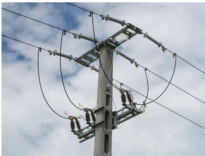
11. Kép Vonal alatti gerincbontó oszlopkapcsoló
