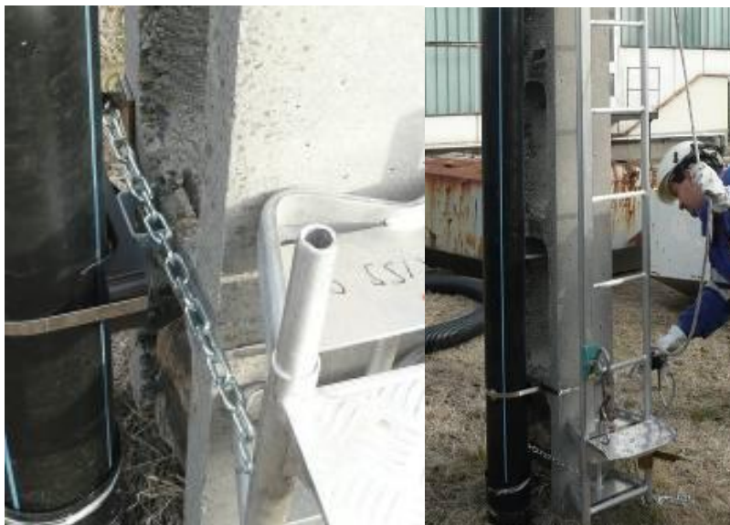
21. Kép A TEMA létra lánca 0,5 m magasan a védőcső és az oszlop között
