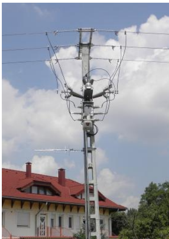
13. Kép Burkolt szabadvezetékes bekötésű TMOK
